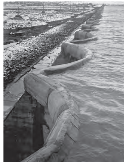
Бетонная плотина, 1931 г.
