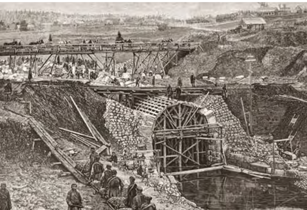
[Рис. 2.21] Строительство моста в Веребье
